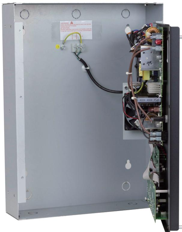
**注記:**スタッドに取り付ける面では、各面4つずつ、8- #10 か同等数の留め具を使用します。裏面取付では、4- 1/4" か同等数の留め具を使用します。留め具は、本機器と固定する材料のタイプによって適切なものにしてください。取付は熟練者または専門家が行ってください。
